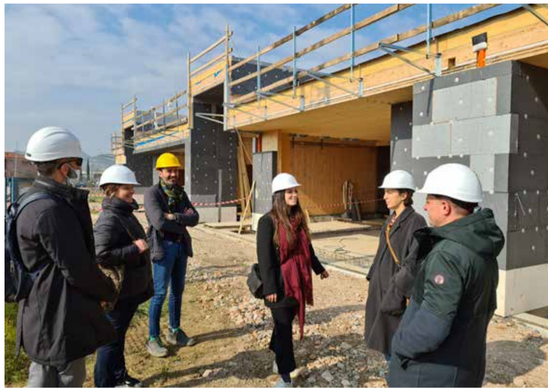
Il sopralluogo della sindaca Alice Parma, della vice sindaca Pamela Fussi, degli assessori Angela Garattoni e Filippo Sacchetti al cantiere per la realizzazione della scuola dell'infanzia di Canonica (a pagina 4 un aggiornamento sui lavori)
