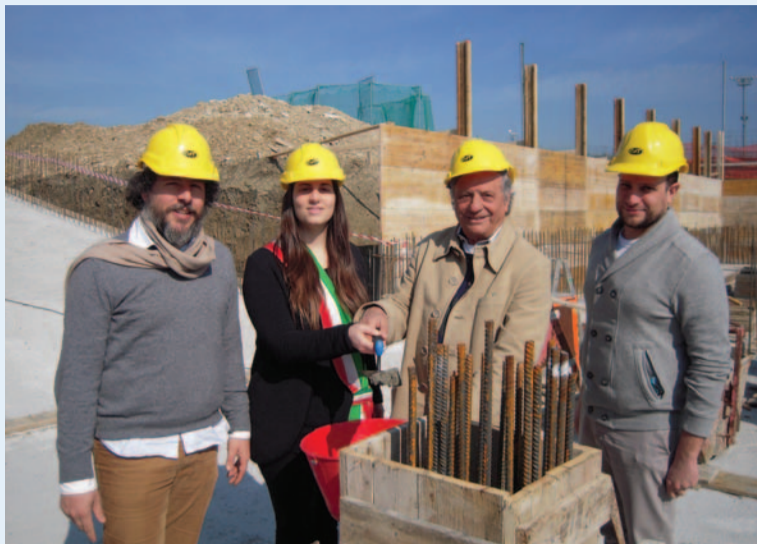
L'assessore Danilo Rinaldi, il sindaco Alice Parma, il titolare della società Immobiliare Fiordaliso Pietro Foschi e l'assessore Filippo Sacchetti all'inaugurazione simbolica del cantiere di via Di Vittorio
