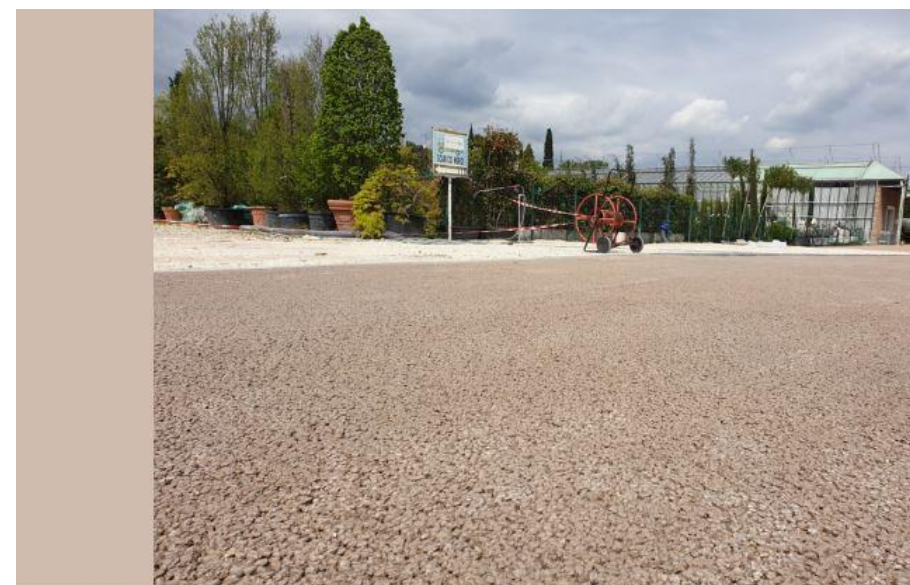
Figura 8 - Cemento drenate color Tabacco per il tratto in campo agricolo
