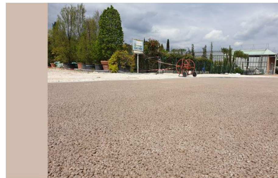
Figura 3 - Cemento drenate color Tabacco per il tratto in campo agricolo
