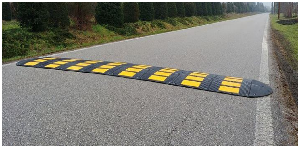
Figura 9: rallentatore di velocità realizzato in elementi modulari prefabbricati
