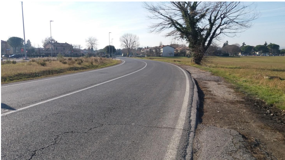
Foto 6 Via della Resistenza in corrispondenza del punto nel quale sarà realizzata la rotatoria di immissione sulla strada di accesso al comparto (e al parcheggio esistente della zona sportiva).
