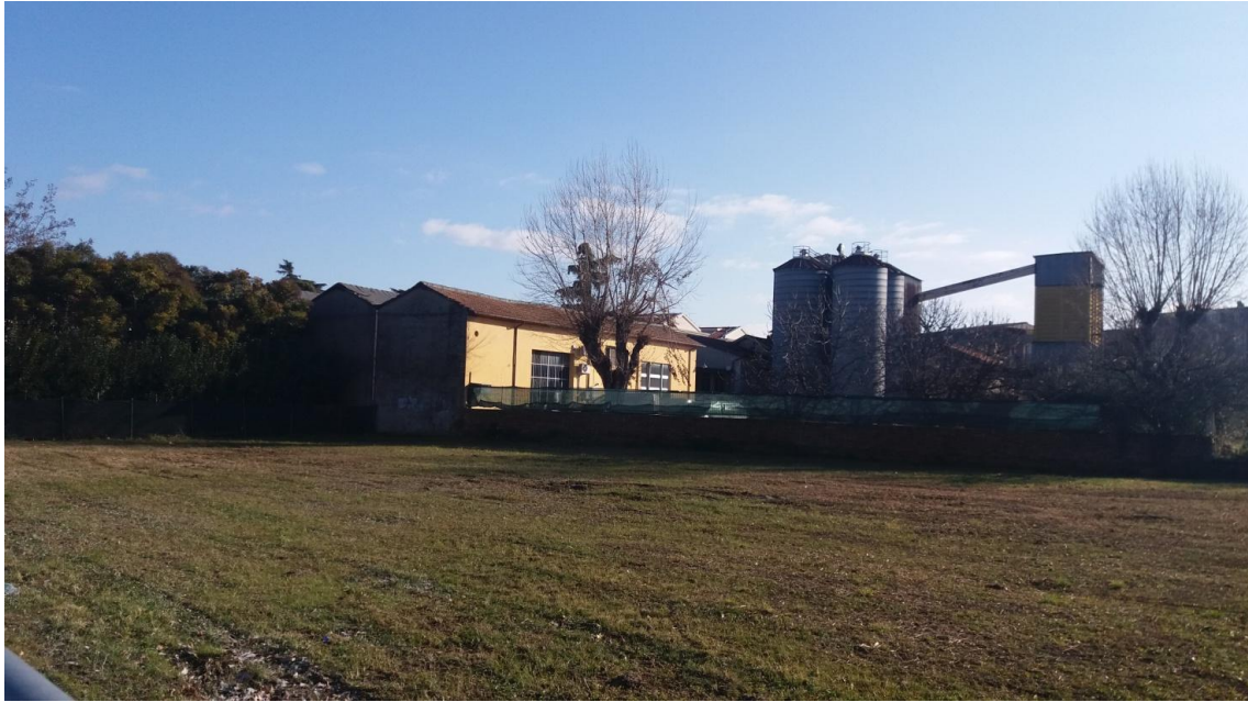
Foto 3 particolare del margine Nord-Est del sub-ambito A. In primo piano gli edifici esistenti (di colore giallo) che verranno demoliti. Sullo sfondo i silos interne ai sub.B non ricompreso nel presente PUA.
