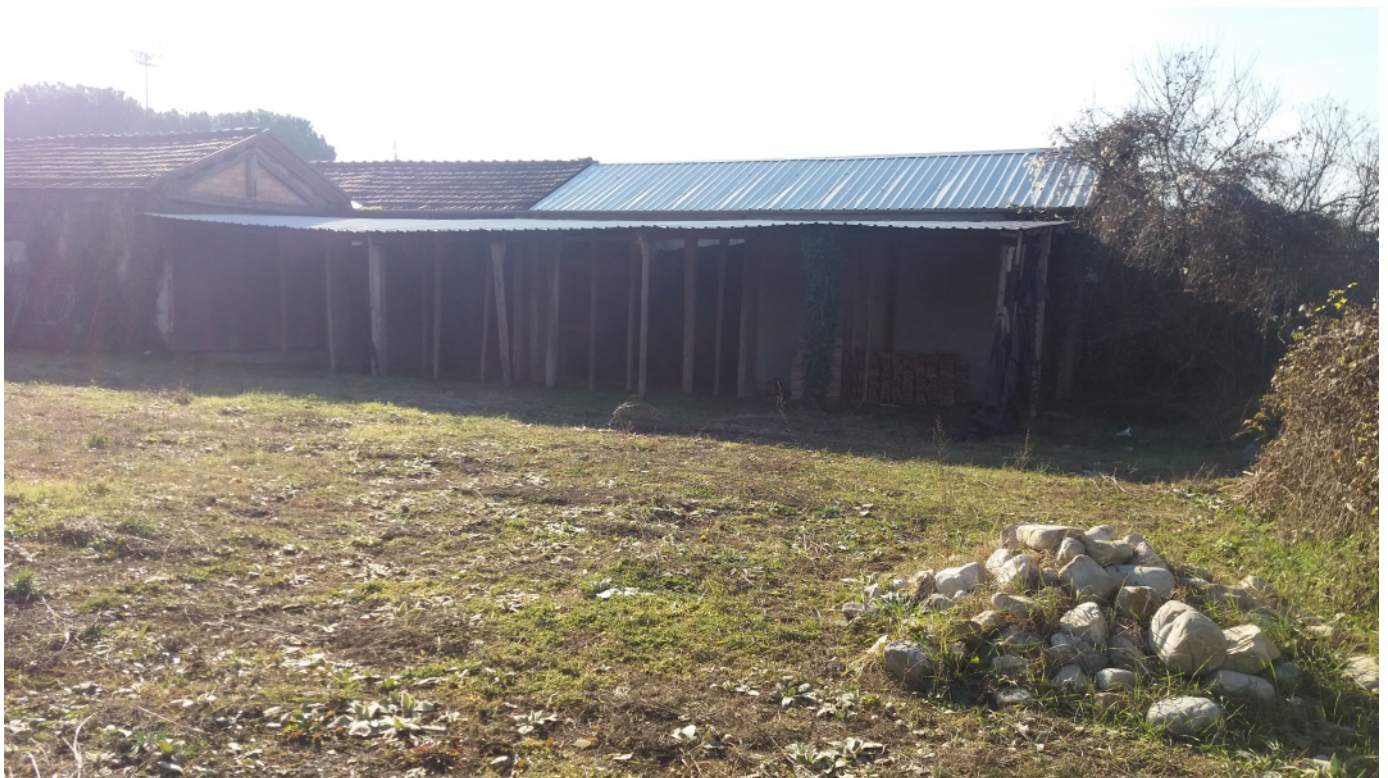
Foto 6 - particolare degli edifici esistenti sulla proprietà Baroni, con vista da Nord.
