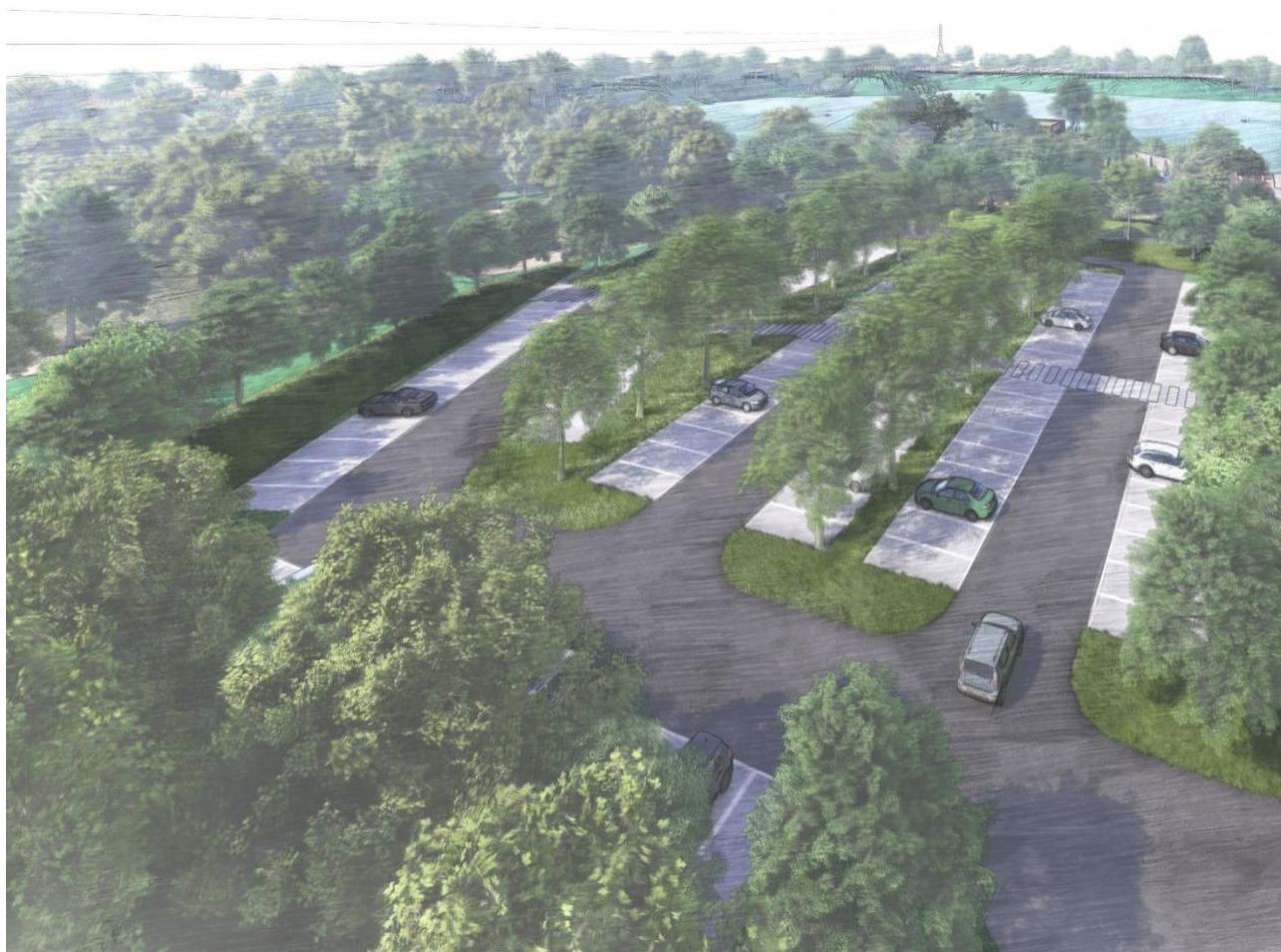
Fig. 30: Il parcheggio pensato come isola verde mitigata dai movimenti terra e dalla vegetazione, in grado di gestire tramite dei rain gardens le acque in eccesso durante eventi piovosi intensi.
