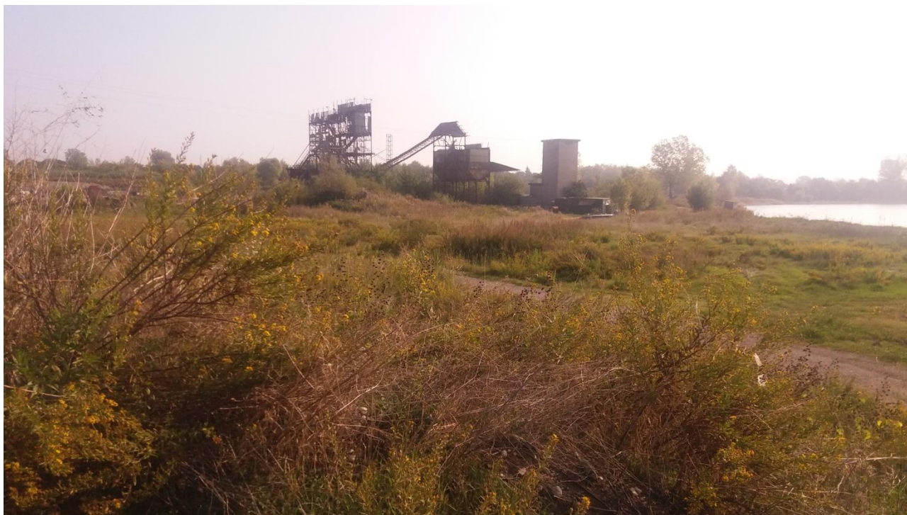
Foto 6 – panoramica della zona ex impianti.
