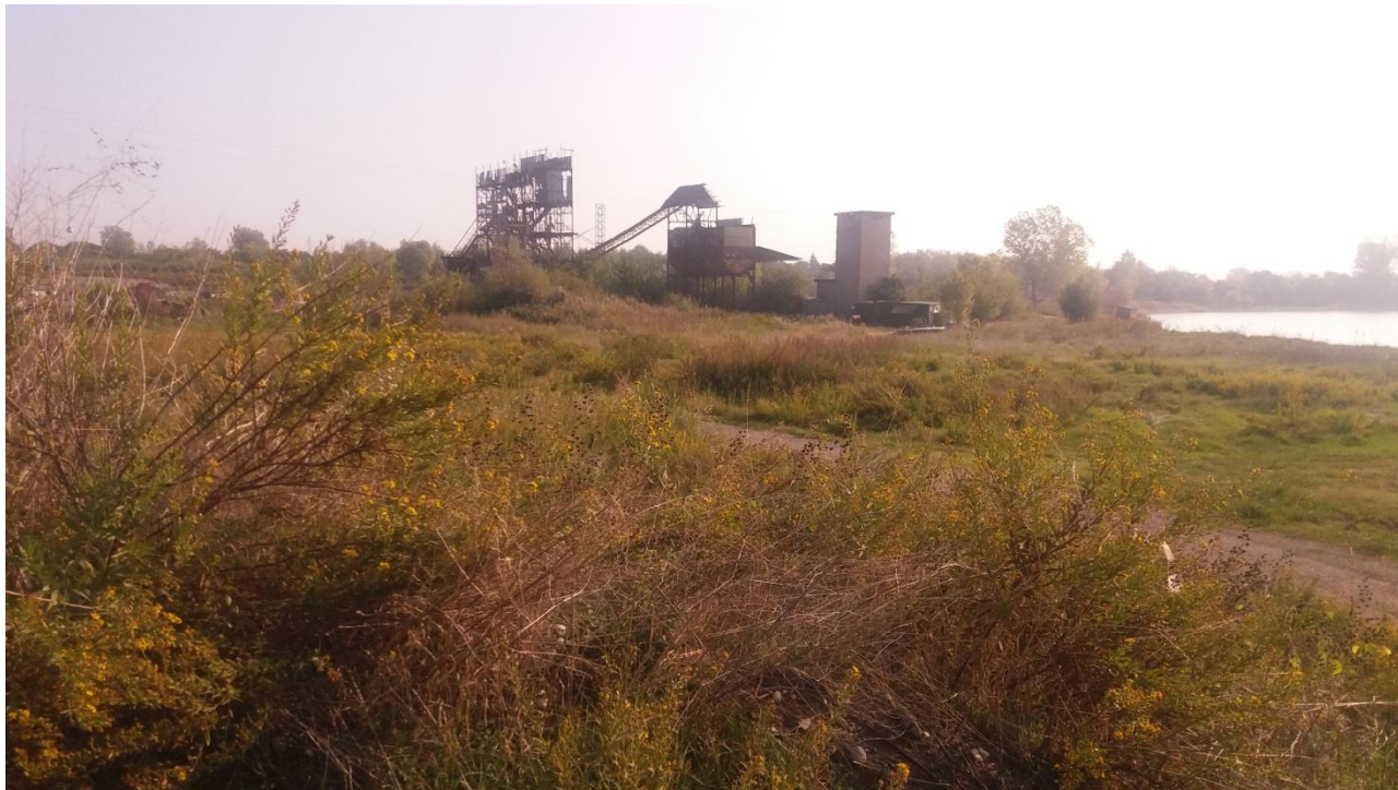
Foto 6 – panoramica della zona ex impianti.
