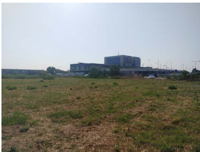
Foto interno comparto lato sud-est
