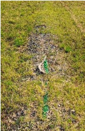
trincea drenante all'interno della vasca di laminazione
