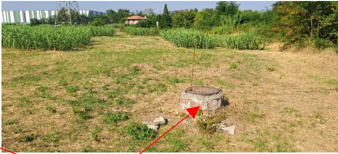
pozzetti rete acque bianche (collegamento alla vasca di laminazione, zona nord in prossimità della ferrovia)
