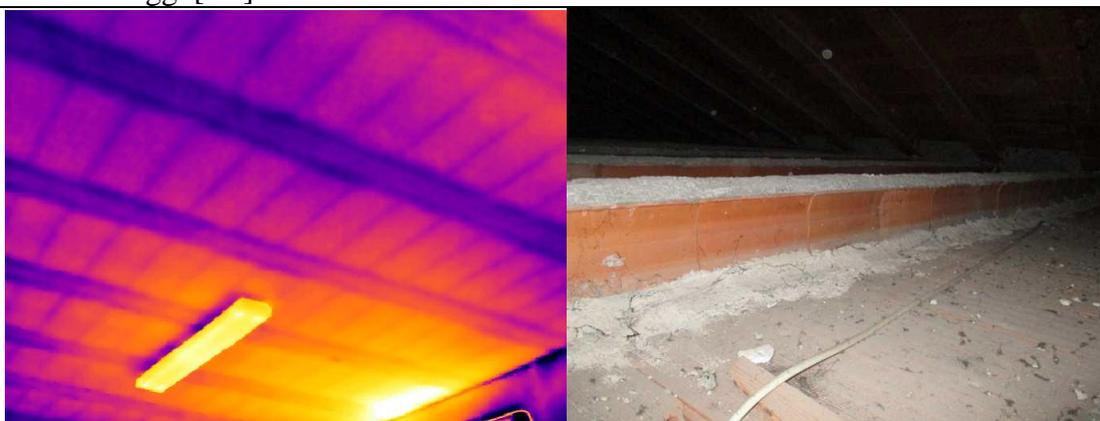
A rendere ancora più difficile la posa dell'isolante nei sottotetti è la mancanza di botole di ispezione e la limitata altezza che quasi in tutti i casi parte da poco più di un metro e arriva a zero contro il soprastante solaio di copertura.
